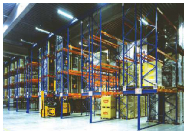
Vychystávací pozice ve tvaru "T" pro zaskladnění a vyskladnění palet různých rozměrů. Často používané pro skladování nábytku.
